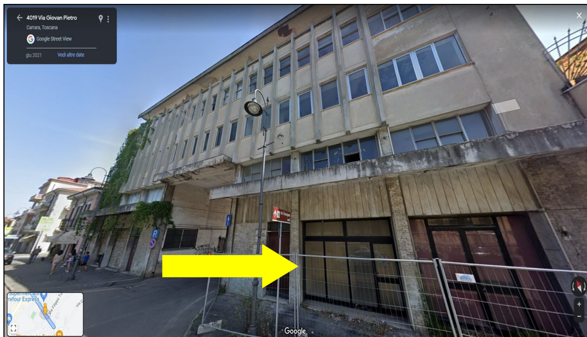
Foto prospetto lato Sud degli uffici al piano terra, da Google Street Map – foto del giugno 2021
