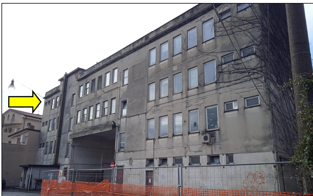
Facciata lato Nord foto del 26/11/2021
